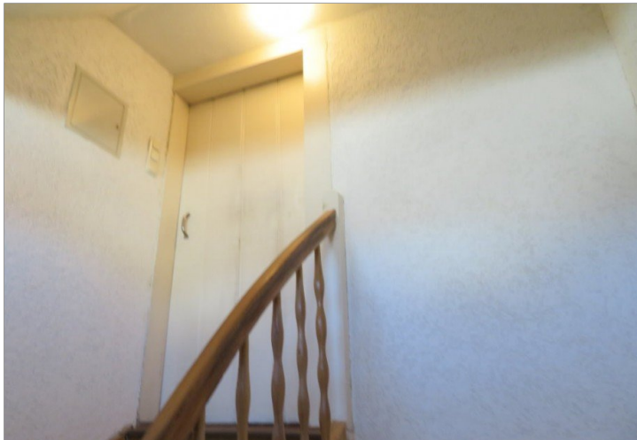
23 Treppenhaus ins Dachgeschoss
