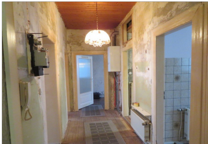
15 1.Obergeschoss Eingang Flur
