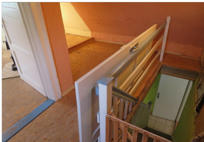
20 Treppe ins Dachgeschoss
