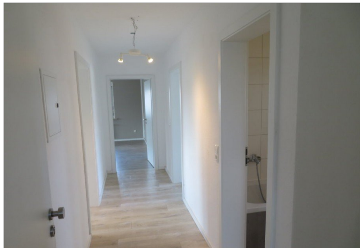
5 Obergeschoss Eingang Flur
