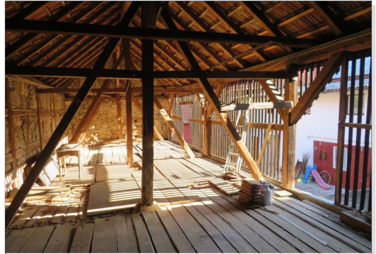
21 Innenhof oberhalb der alten ställe RÜCKGEBÄUDE
