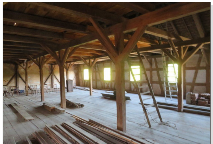
23 Dachgeschoss Scheune RÜCKGEBÄUDE
