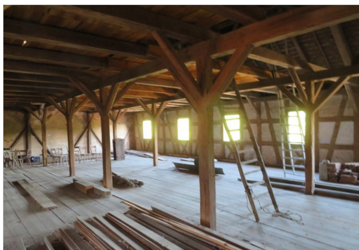
23 Dachgeschoss Scheune RÜCKGEBÄUDE
