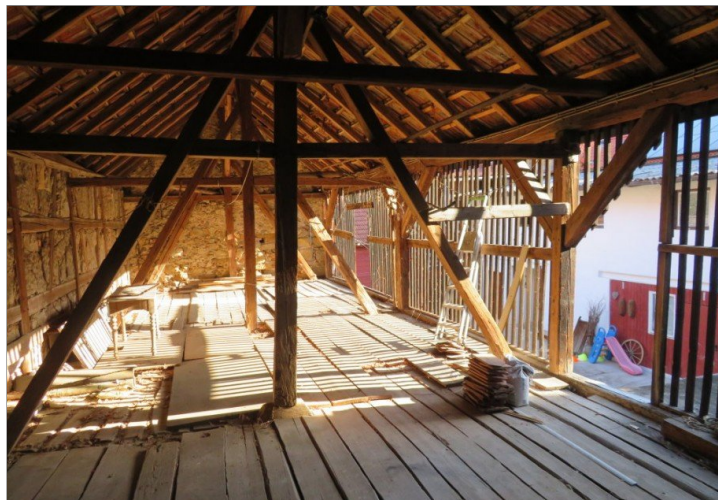
21 Innenhof oberhalb der alten ställe RÜCKGEBÄUDE
