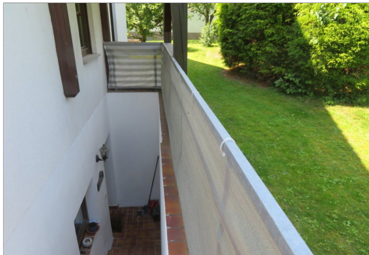
18 Zugang Kellergeschoss Einliegerbereich
