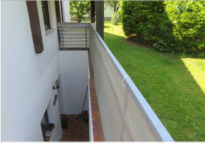
18 Zugang Kellergeschoss Einliegerbereich
