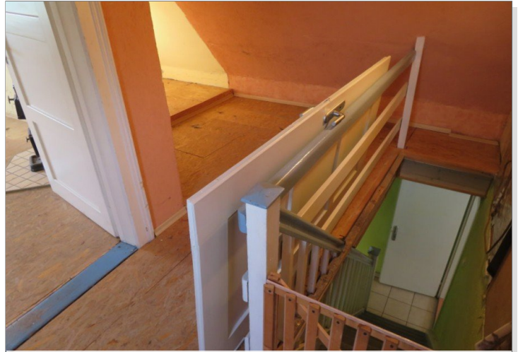
20 Treppe ins Dachgeschoss
