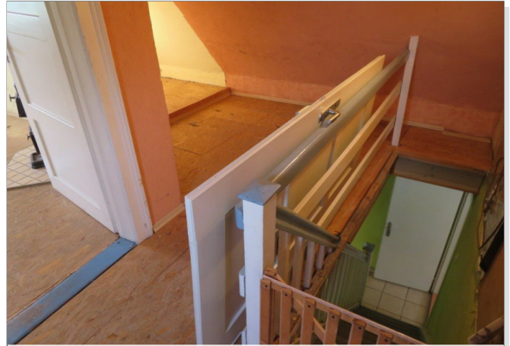
20 Treppe ins Dachgeschoss
