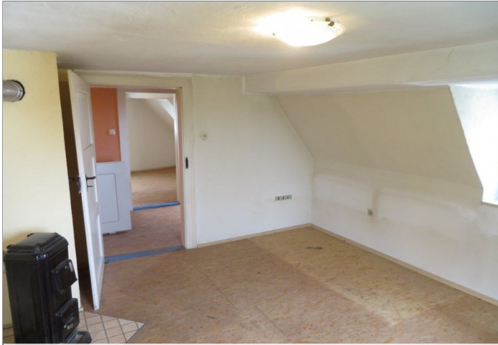
23 Dachgeschoss Raum 1+Blick Raum 2
