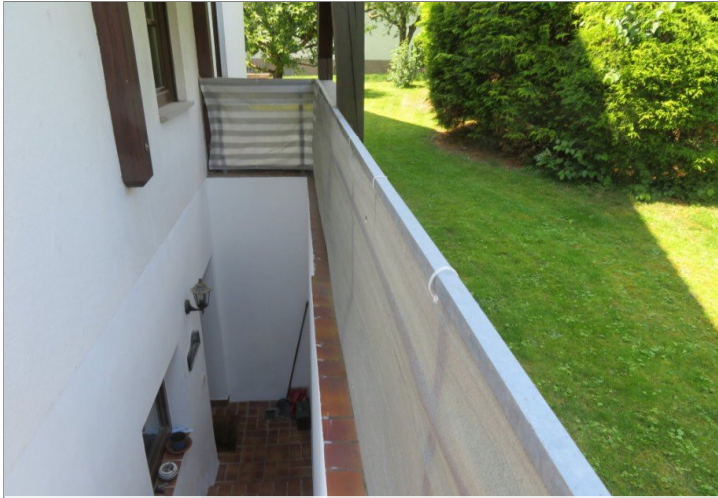
18 Zugang Kellergeschoss Einliegerbereich
