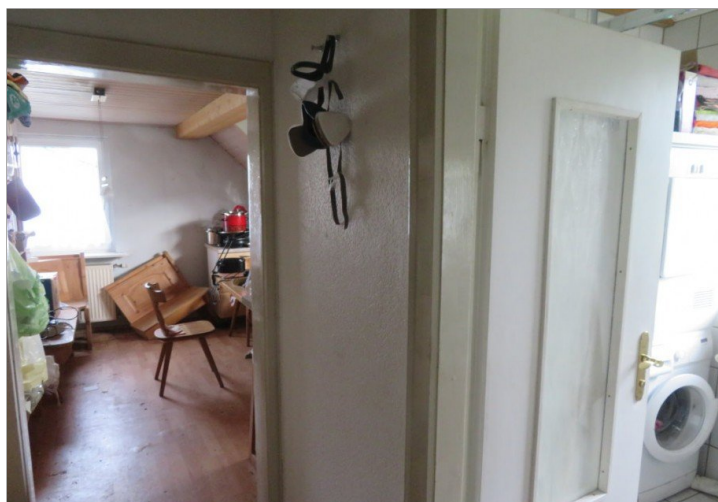
16 Dachgeschoss Blick zur Küche
